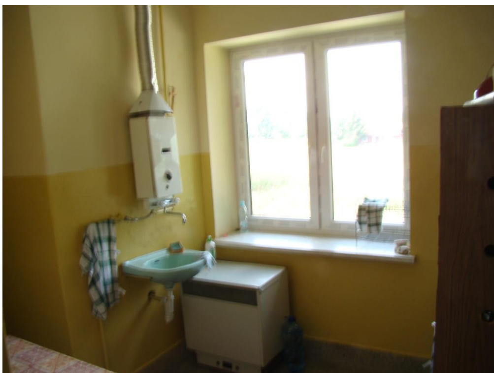
Pomieszczenie socjalne przed remontem
