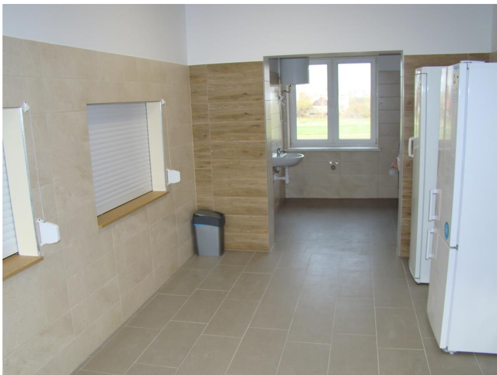
Pomieszczenie socjalne po remoncie
