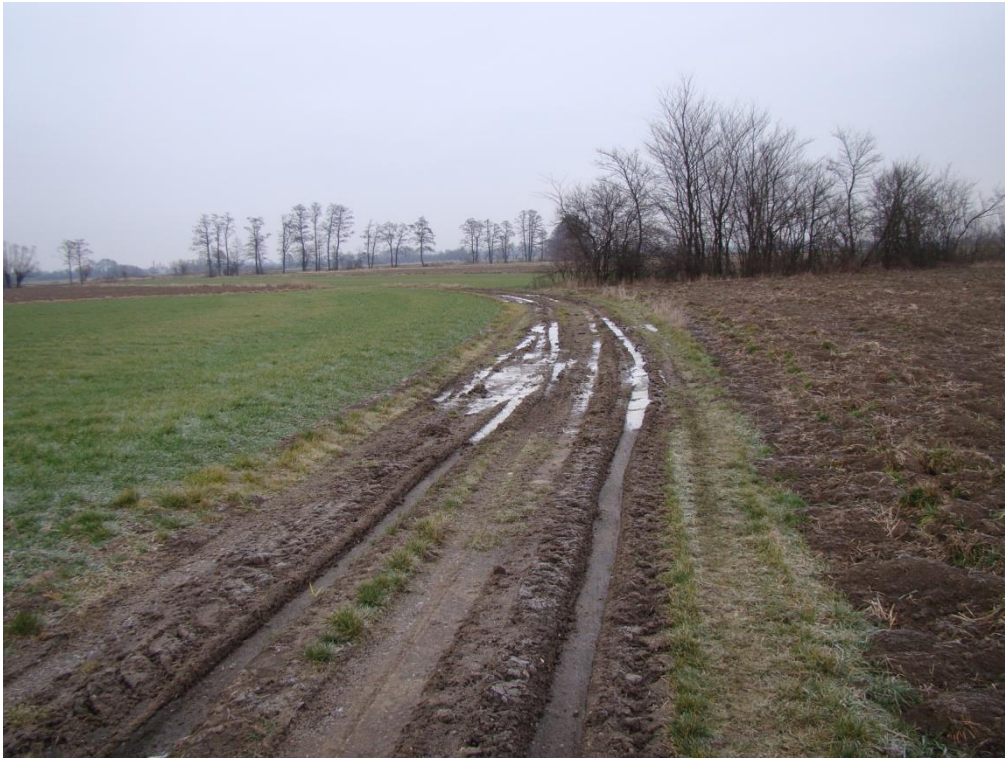
Fot. Nr 4 – Widok w km 0+700 przed wykonaniem. Data: stan w dniu 7 lutego 2020 r.
