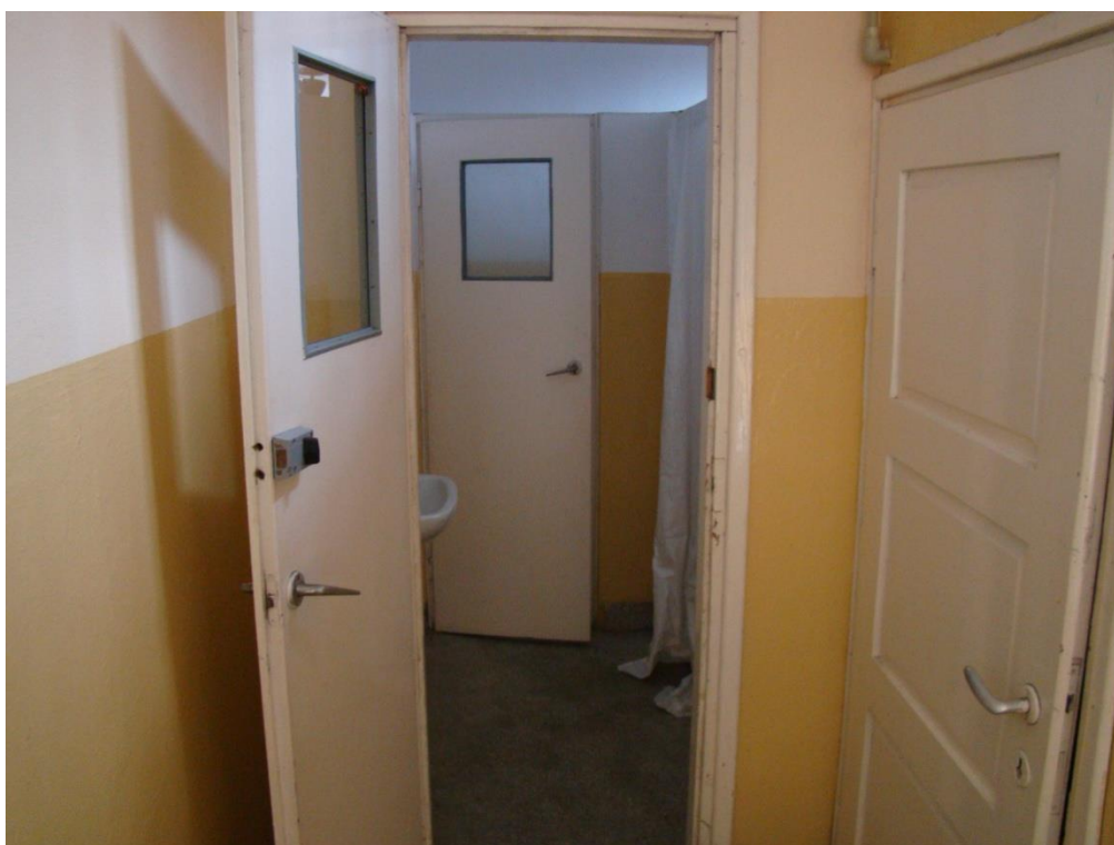
Pomieszczenie sanitarne przed remontem
