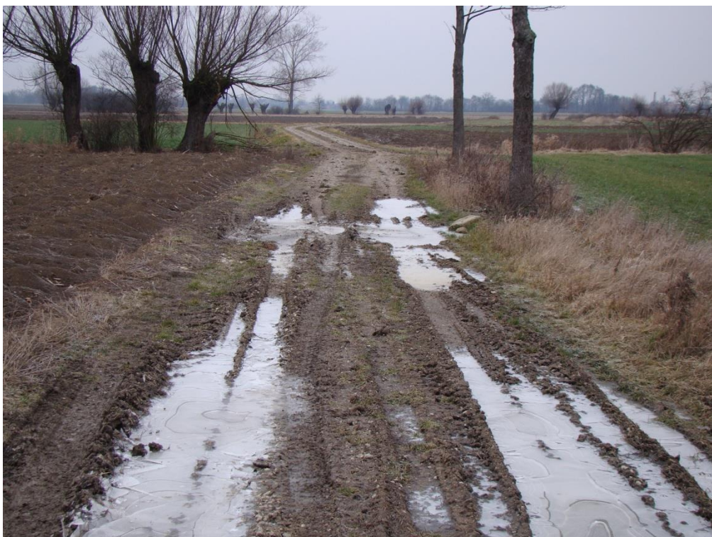
Fot. Nr 5 – Widok w km 0+925 przed wykonaniem Data wykonania: stan w dniu 7 lutego 2020 r.
