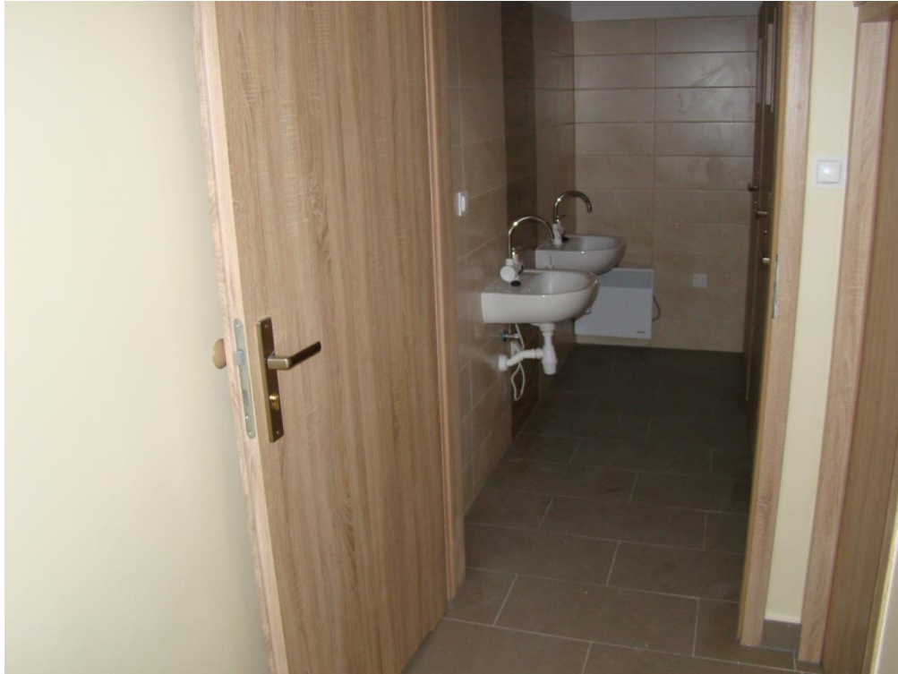
Pomieszczenie sanitarne po remoncie
