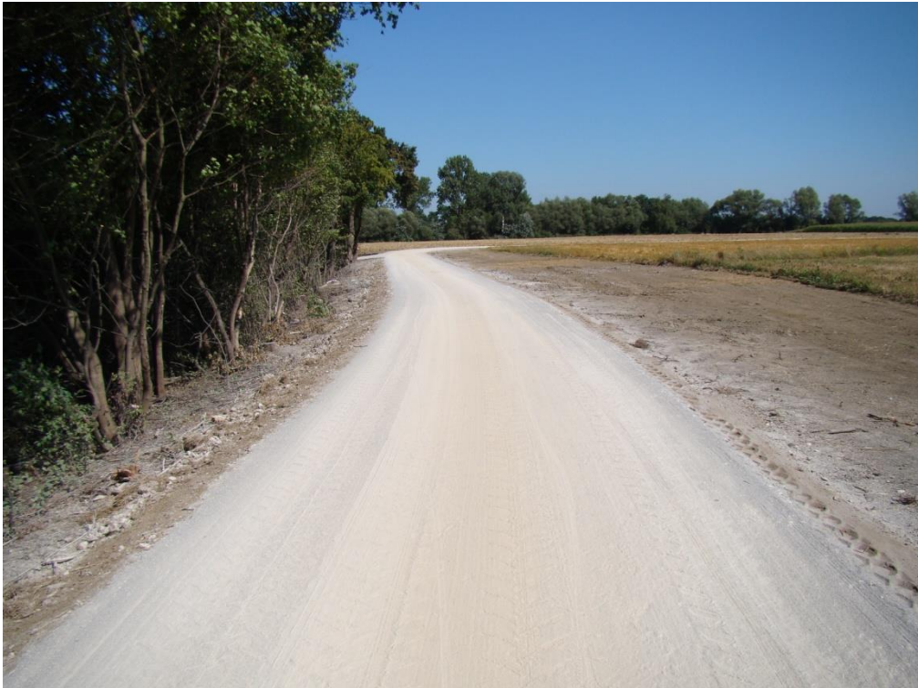
Fot. Nr 3a – Widok w km 0+500 po wykonaniu. Data: stan w dniu 14 sierpnia 2020 r.
